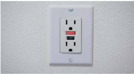
接地漏电保护插座，英文 Ground Fault Circuit Interrupter, 简称 GFCI。它是一种应用于家庭住所，以保护用户免受漏电、电击的危害的一种实用性电气产品。现在新造或改建房子的厨房厕所都规定要安装 GFCI 漏电保护插座。我个人觉得为了安全任何有可能碰到水的地方最好换成 GFCI 插座，如厨房，厕所，室外, sump pump (如果房子地下室有这个装置)和喷水池等。
