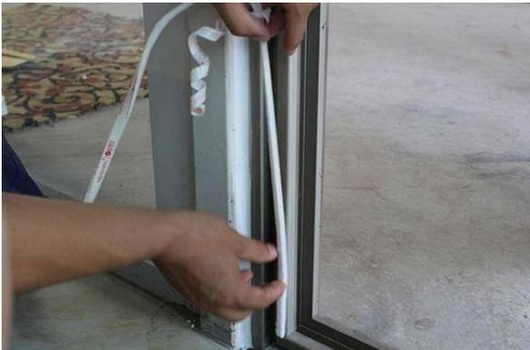
如果门窗的密封性不好，则屋内的热气会大量泄漏出去而造成浪费。所以首先要保证这些门窗的密封性：如保证门窗胶条的气密性良好，**caulking**要到位，并在门底下加装密封条。
